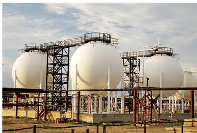
Figura 1. Almacenamiento de gas natural licuado a presión atmosférica y temperatura  $-161\text{ }^{\circ}\text{C}$ . En su interior no hay aire luego no es de aplicación el Real Decreto 681/2003.
