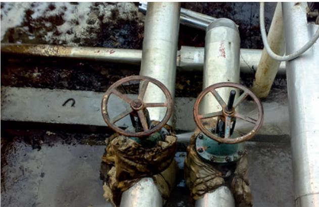
Figura 17. Fallos en bridas, válvulas y elementos de unión.
