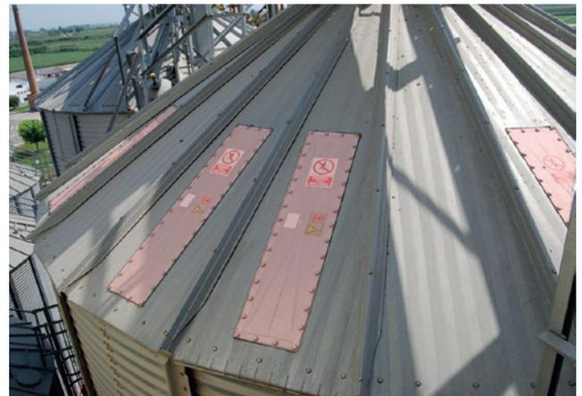
Figura 26. Paneles de venteo instalados en un silo para que en caso de explosión no supongan un peligro para los trabajadores ni afecte a otros equipos.
